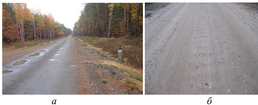
Рисунок 1 – Виды разрушений на автомобильных дорогах
