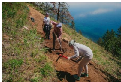
Рисунок 3 – Устройство зеленой тропы с грунтовым покрытием
