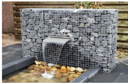
Рисунок 2 – Небольшой водопад, встроенный в габрион [5]
