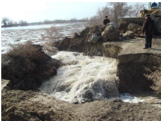
Рисунок 5 – Прорыв плотины Кызыл-Агашского водохранилища
