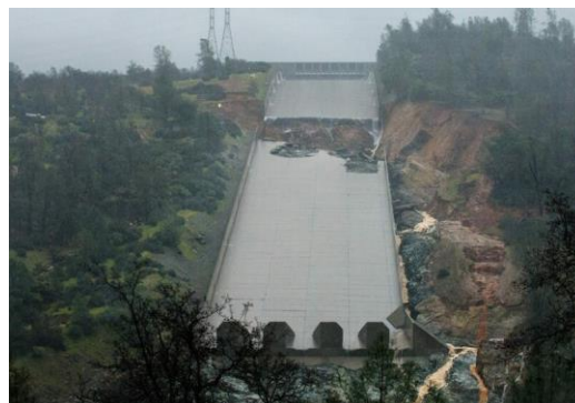
Рисунок 4 – Авария на Оровильской плотине, США
