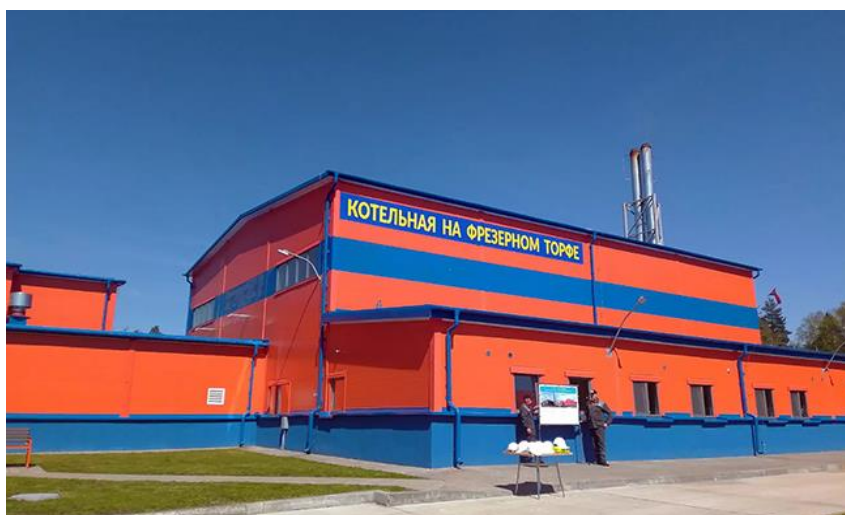
Рисунок 2 – Современная отопительная котельная введена в эксплуатацию в 2022 г.
